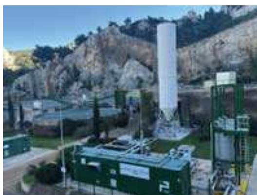
Mise en service en 2019, l'unité de méthanisation permet de transformer les boues issues du traitement des eaux usées de 17 communes, en biogaz avant de l'injecter dans le réseau public.
